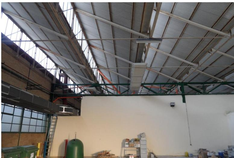
Fig.3 vista della copertura a sheds
