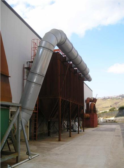
Impianto di abbattimento. In primo piano il filtro a maniche sullo sfondo la camera di calma con il ciclone.
