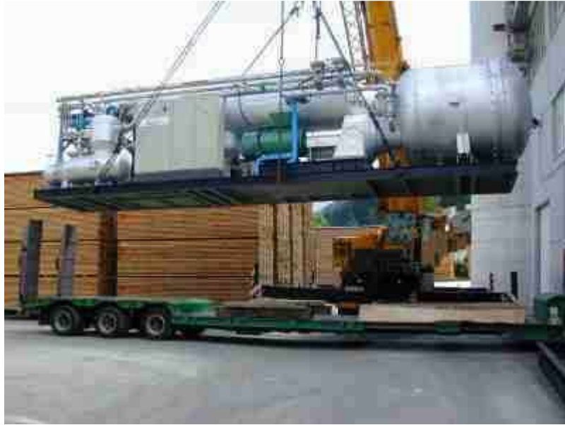
Figura 28 Impianto ORC da 400 kWe (fonte: http://www.ieabcc.nl/ )
