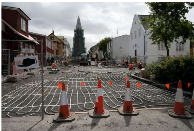
Figura 35 Riscaldamento geotermico delle strade per eliminare il ghiaccio (fonte: http://www.thinkgeoenergy.com )
