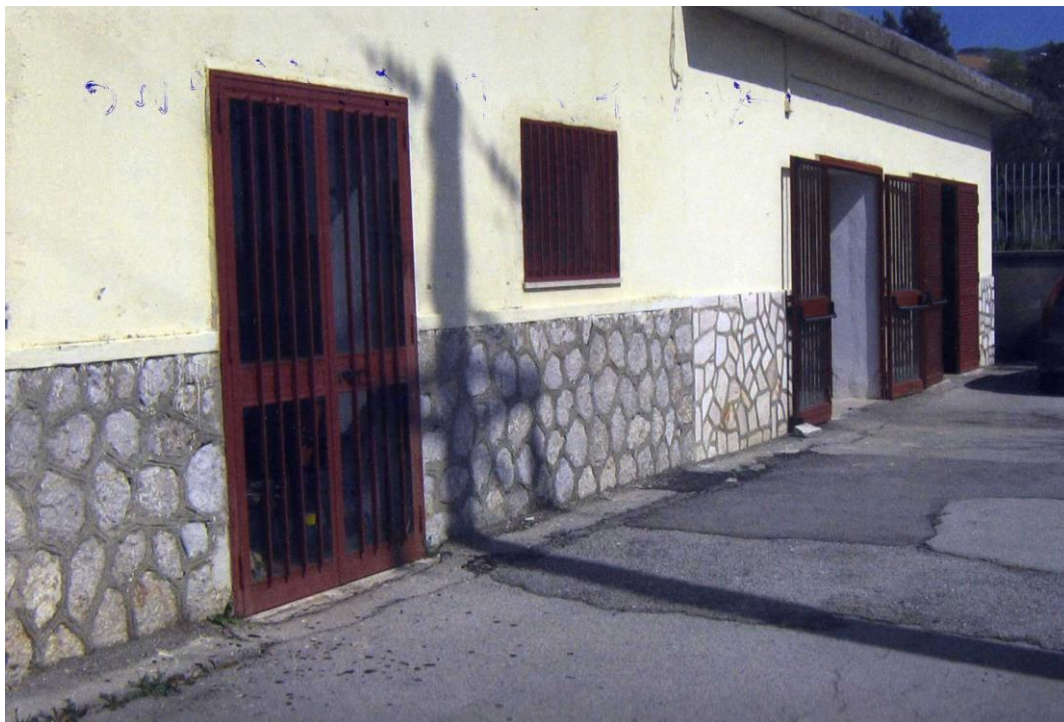
Centrale Sollevamento Caggiano
