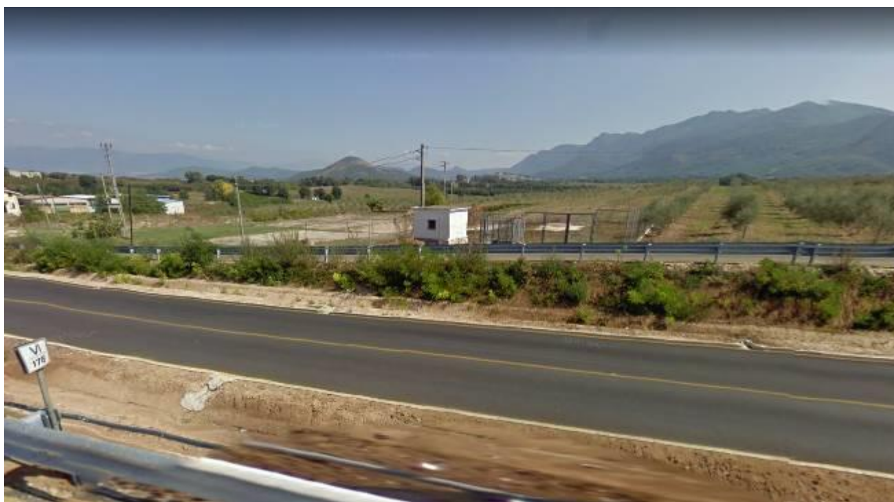
TW31: pozzo produzione CO 2 – SS6 Casilina
