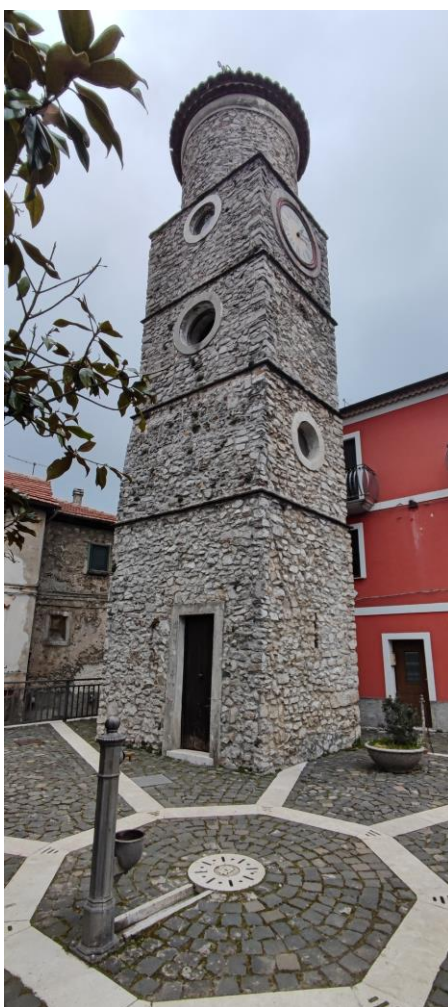
Figura 13 - Torre campanaria di San Martino
