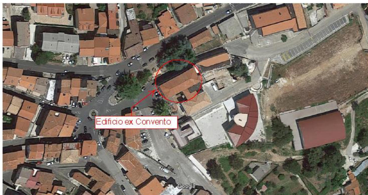
Figura 10 - Edificio Ex Convento
