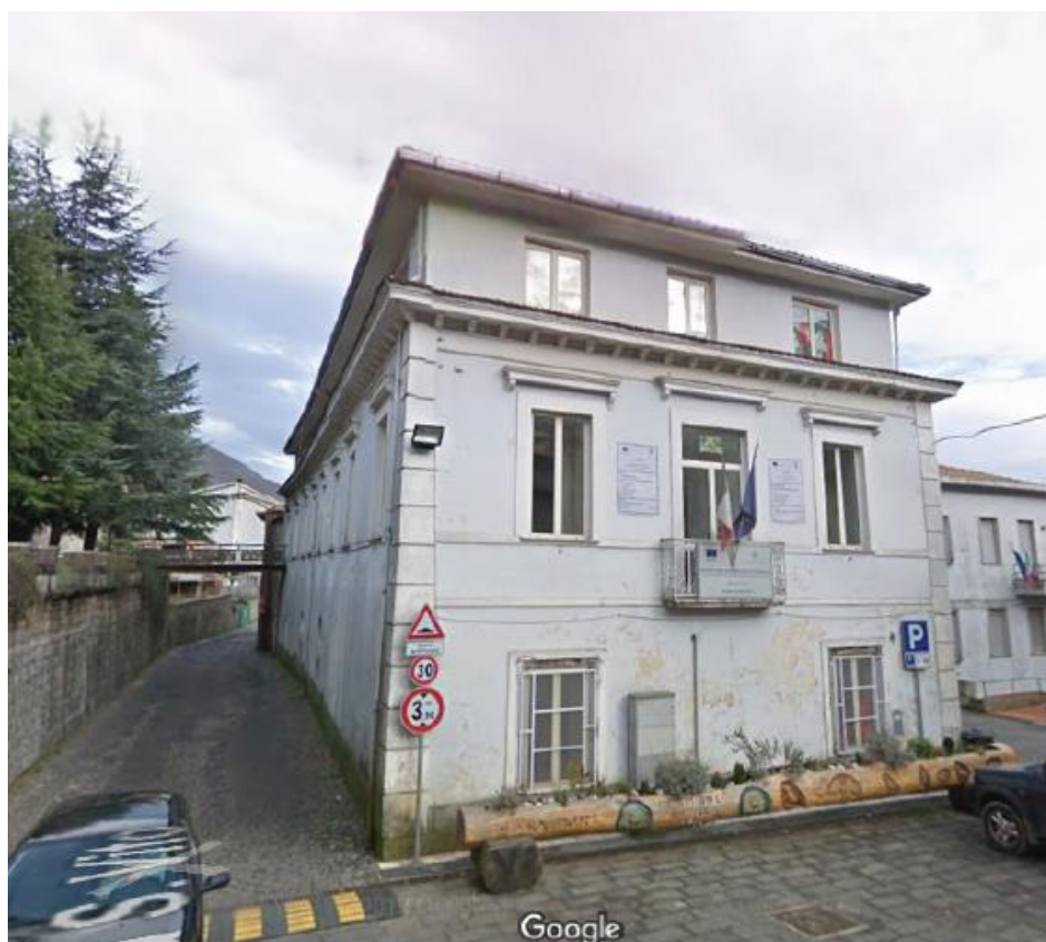
Figura 11 - Vista dell'edificio Ex Convento
