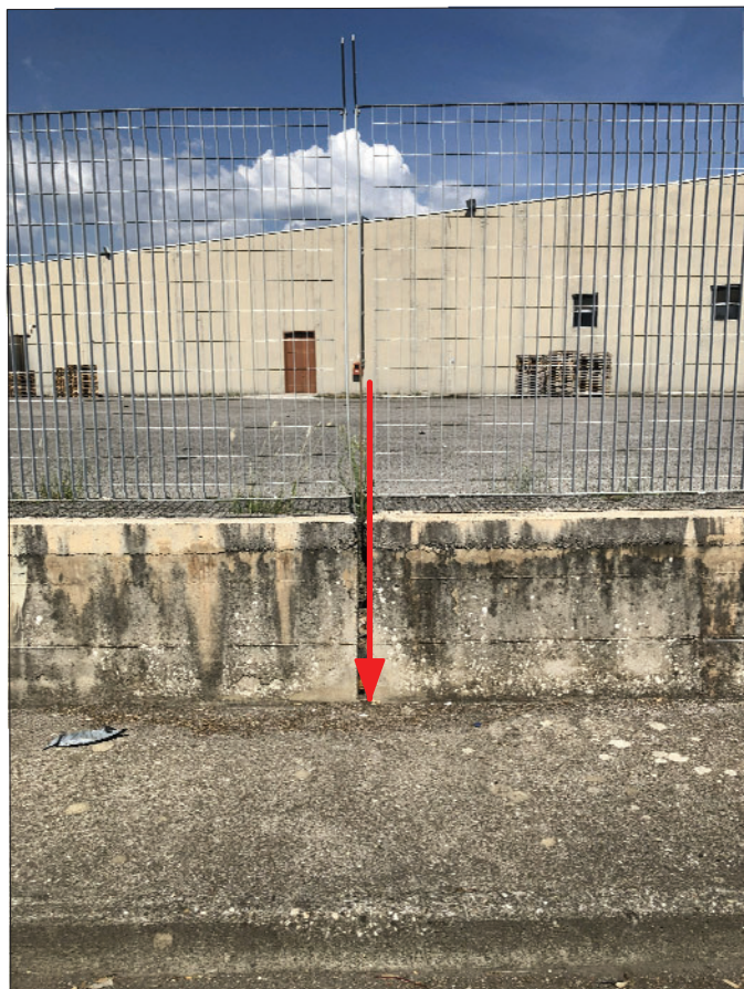
RILIEVO FOTOGRAFICO DEL VERTICE
