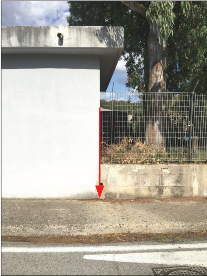
RILIEVO FOTOGRAFICO DEL VERTICE
