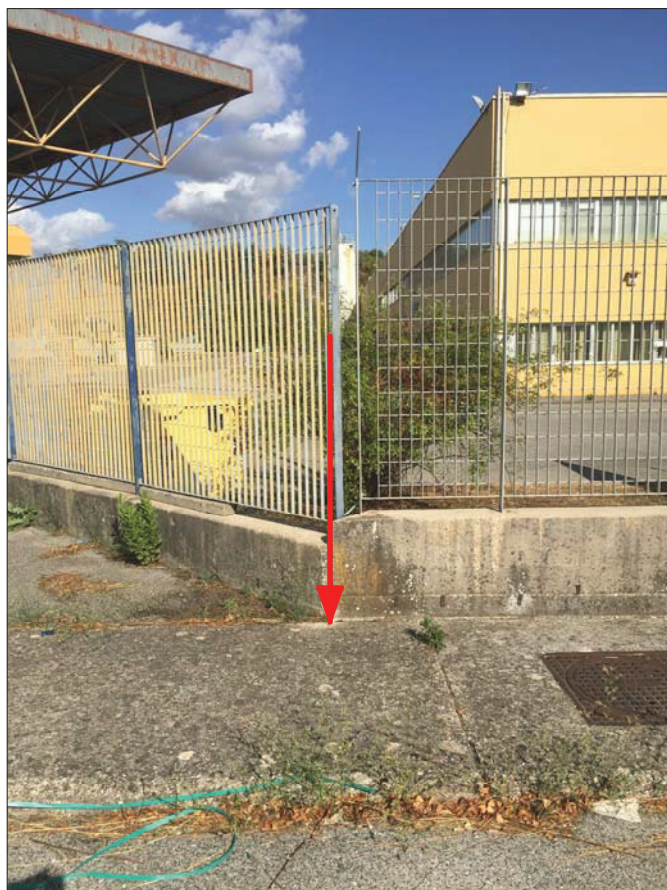
RILIEVO FOTOGRAFICO DEL VERTICE
