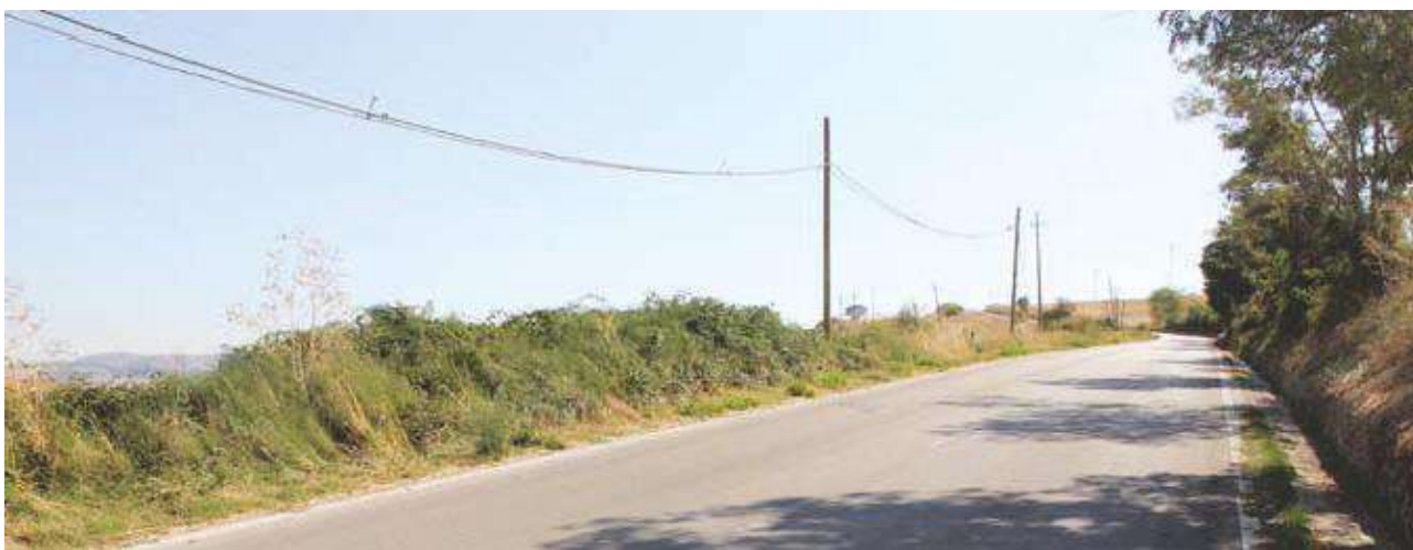
Figura 6 – Strada Serritelli – Chiancarelle a circa metà del percorso del cavidotto esterno interessata dalla posa del cavo dell'impianto di rete
