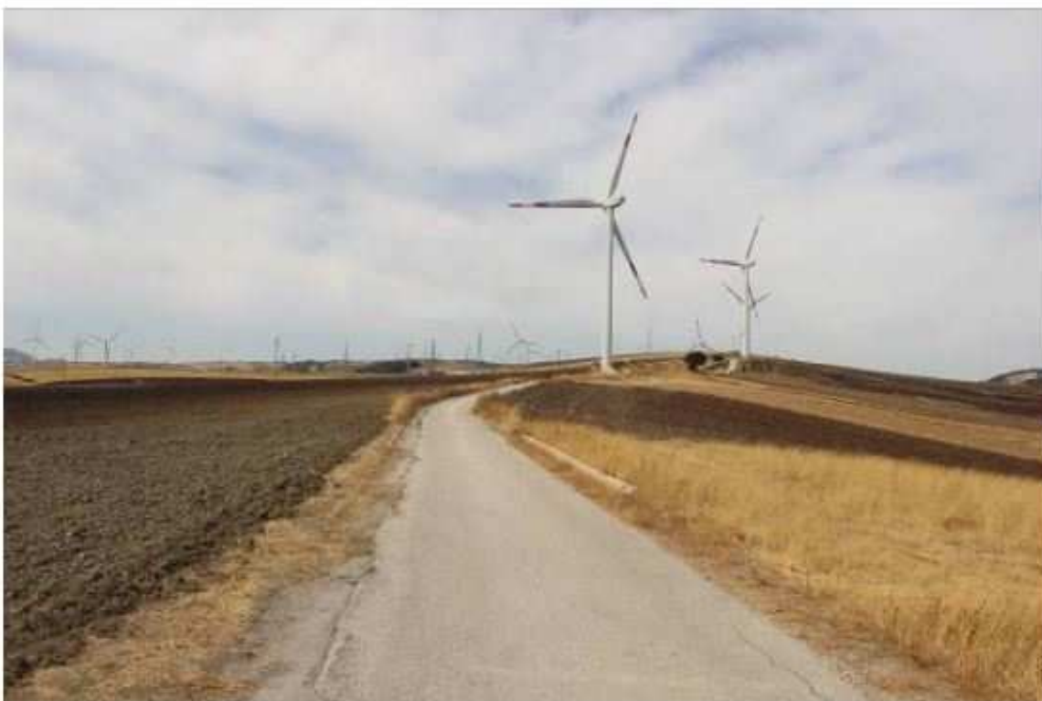
Foto 4. Strada interessata dalla posa del cavo dell'impianto di rete a circa metà del percorso del cavidotto
