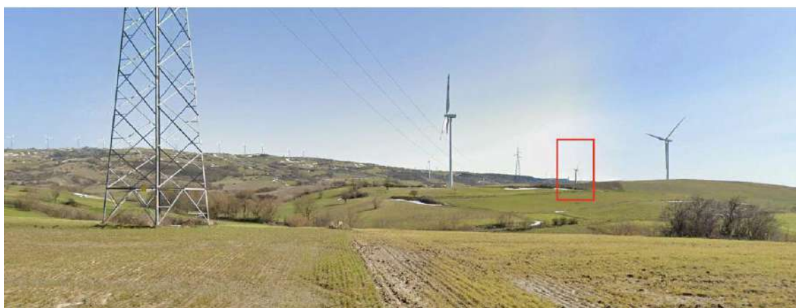
Vista dell'impianto da Nord-Ovest (su SP116 in prossimità della frazione Franzese)
