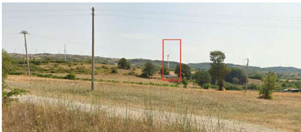
Vista dell'impianto da Ovest (su SP116)
