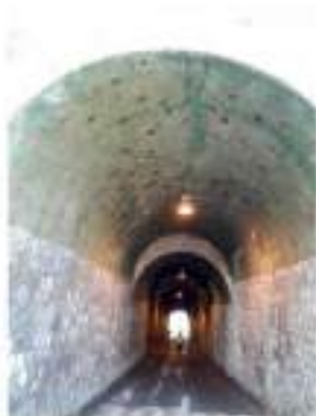
Figura 1.3 - Vista FRP ed intonaco all'interno
