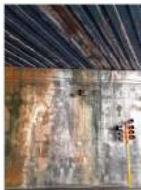
Spalla lato Pozzuoli: disgregazione mattoni, perdita manto nei giunti, infiltrazione attraverso la muratura
