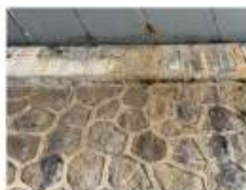
Figura 1.4 - Percolazione d'acqua nelle zone (B appoggio) e conseguente distacco di terreno per ossidazione
