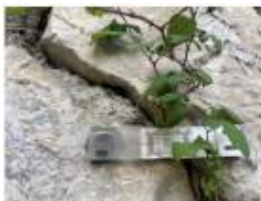
Figura 1.6 - Fessurimetro in corrispondenza della lesione del muro d'ala di Spalla 1
