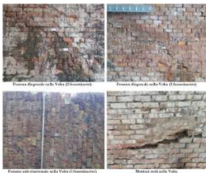
Fessura sub-trasversale nella Volta (3 fotografata)
