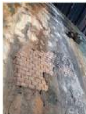
Spalla lato Pozzuoli: disgregazione mattoni, perdita manto nei giunti
