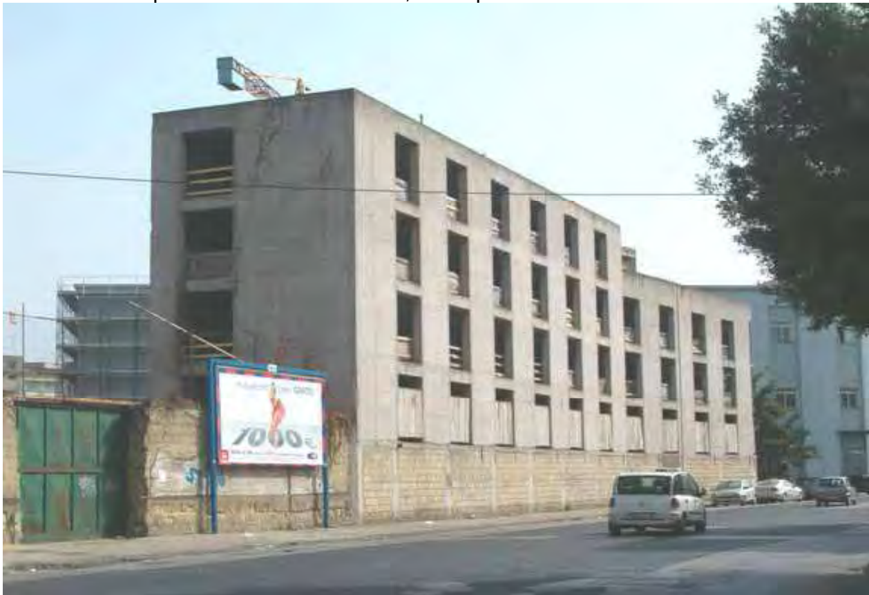
FOTO 1 Primo piano dell'edificio Via Brin, 69 Napoli.
