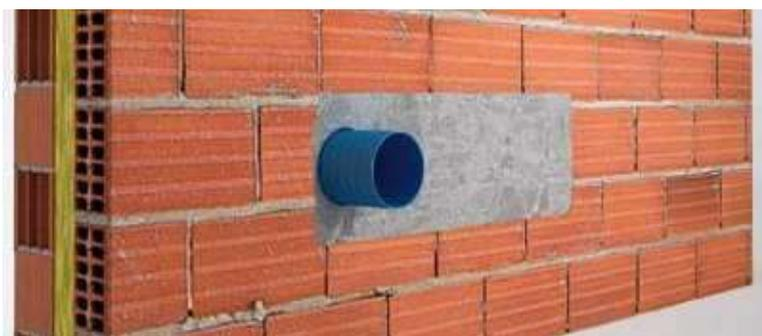
Fase 4: una volta asciugata la muratura, si provvederà a rifilare la parte sporgente.
