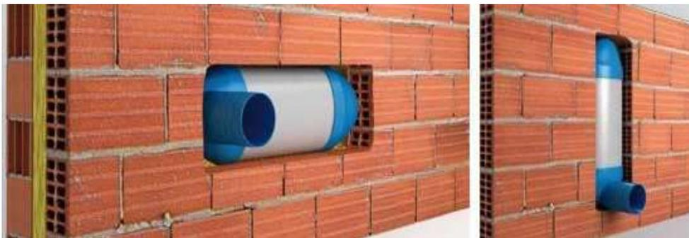
Fase 3: una volta posizionato il silenziatore, chiudere la traccia con mattoni e/o malta cementizia, lasciando fuoriuscire la parte curva del sistema di ventilazione sia all'interno che all'esterno della parete.
