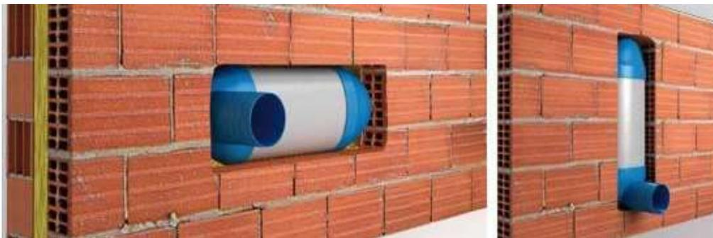
Fase 3: una volta posizionato il silenziatore, chiudere la traccia con mattoni e/o malta cementizia, lasciando fuoriuscire la parte curva del sistema di ventilazione sia all'interno che all'esterno della parete.
