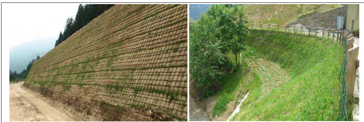
Esempi di realizzazione di terre rinforzate: al termine della messa in opera (a sinistra) e dopo circa due anni (a destra)
