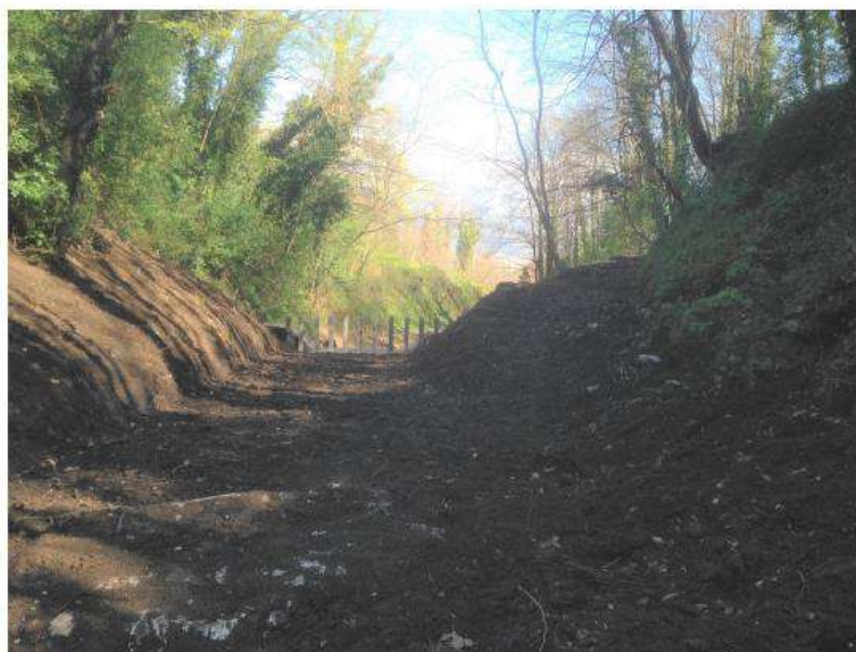
Figura 9 – Pista esistente che sarà utilizzata per la manutenzione
