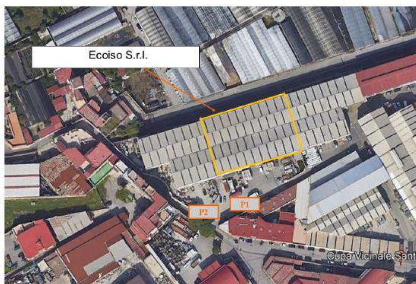
FIGURA 4.1A - INQUADRAMENTO PUNTI DI MISURA ESTERNI AL CAPANNONE IN DATA 13.06.2024
