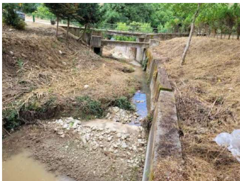
Immagini a monte del torrente e rispetto il ponte di Via Perriello (cono ottico 8)
