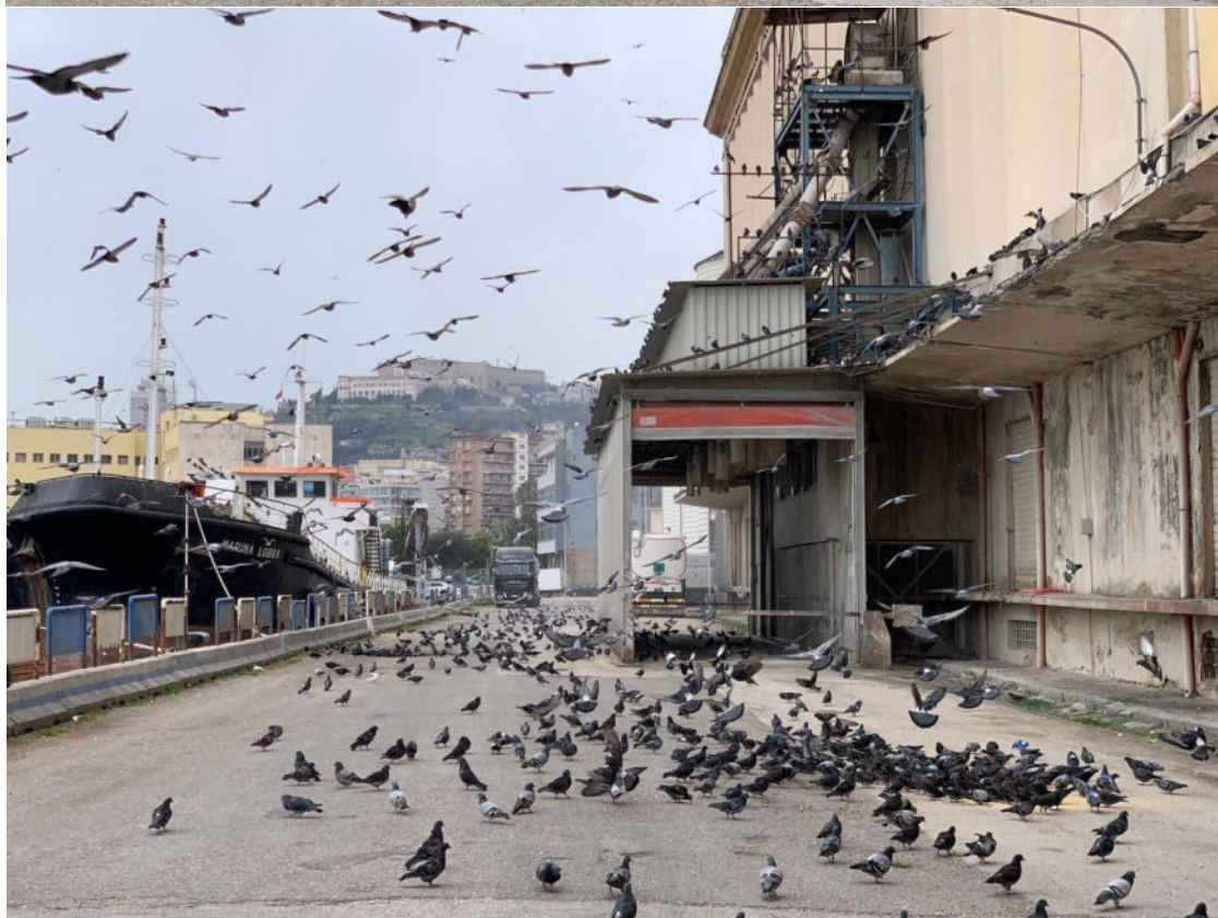
Foto 9 e 10 – Punto di carico (Tunnel) - contaminazione
