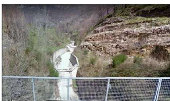
VISTA 3 Vasca 3 - Stato di fatto
