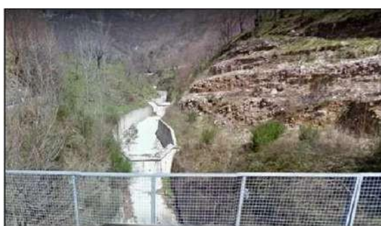
VISTA 3 Vasca 3 - Stato di fatto
