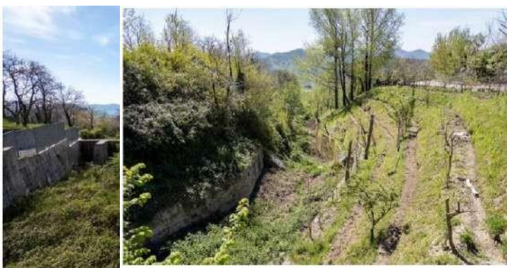
Documentazione fotografica dello stato di fatto
