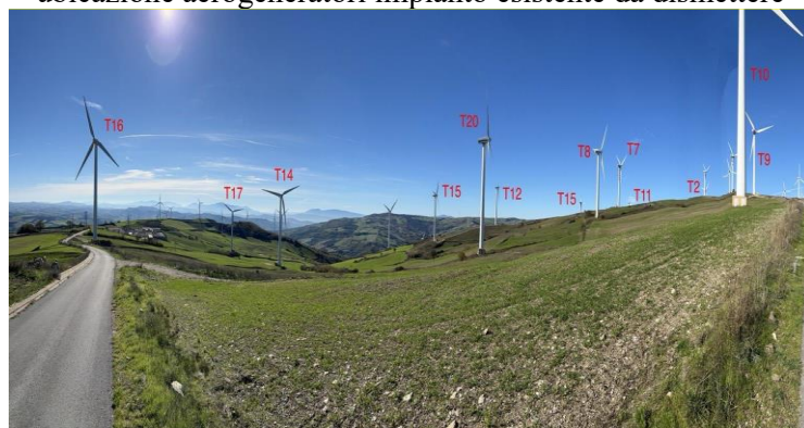
impianto esistente da dismettere
