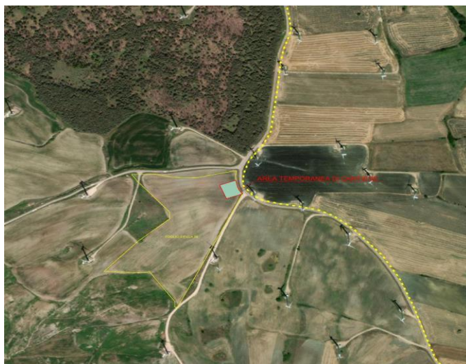
area di cantiere temporanea
