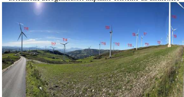
impianto esistente da dismettere
