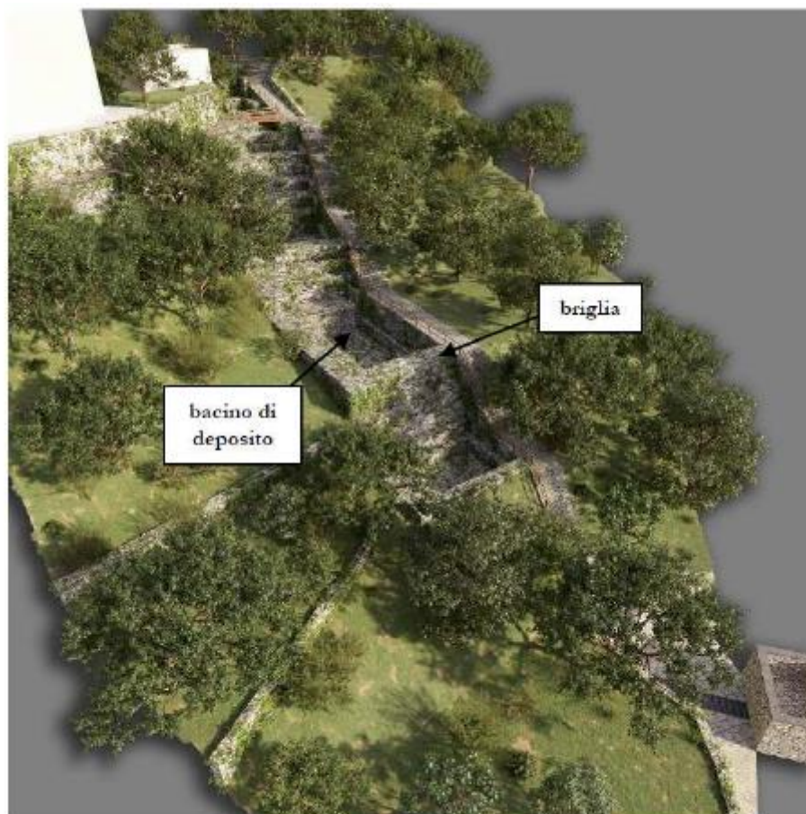
Figura - vista 3d della sistemazione idraulica
