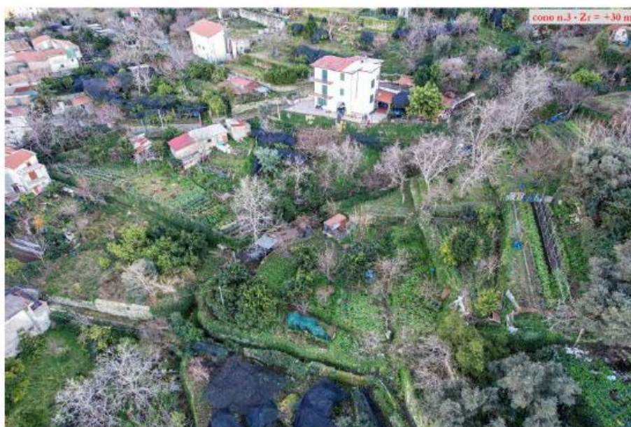
Vista aerea stato dei luoghi
