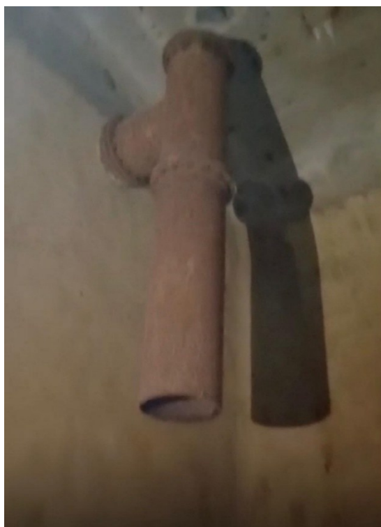
Condotta di carico
