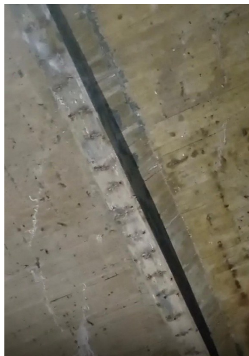
Giunto solaio a voltina di copertura
