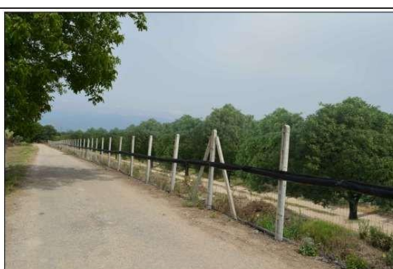
F.AD1 POST OPERAM - Marzano Appio (CE): area di dettaglio vista impianto nord-est.
