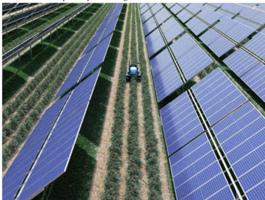
Figura 12 – dettaglio dell'impianto fotovoltaico
