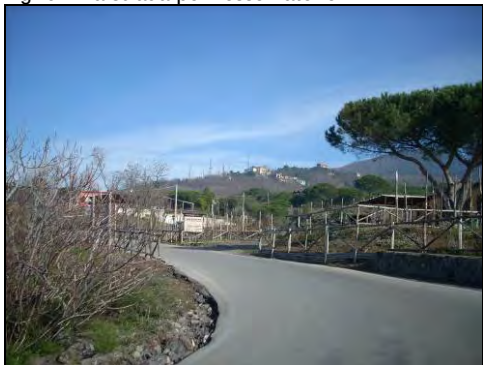
Fig. 62: Dettaglio della strada da Ercolano
