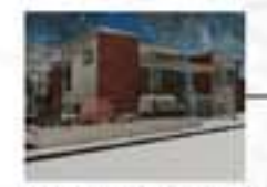
20. Recupero immobile dell'ex centro sociale in via Lago
