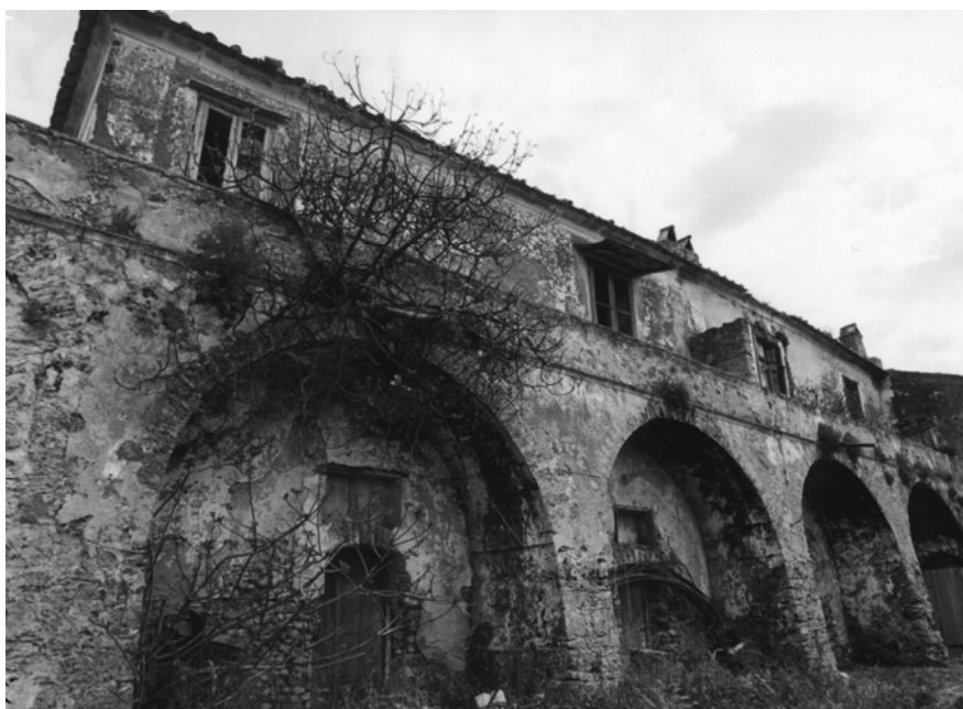
Figura 105. Complesso San Mattia - Particolare.
