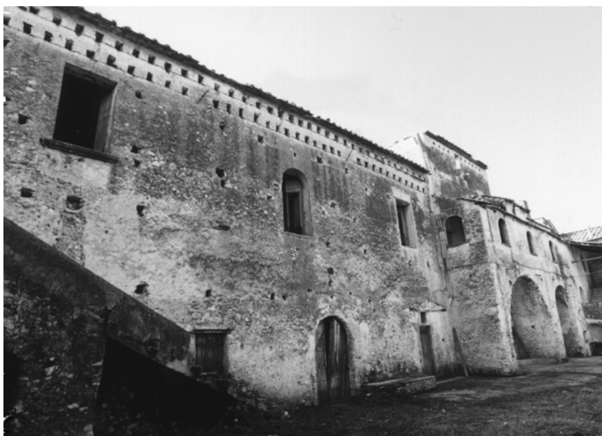
Figura 108. Masseria del Fosso - Particolare.
