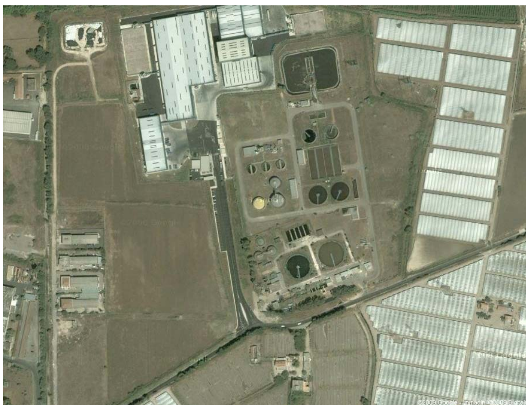
Figura 47 Particolare degli impianti ex FIO ed ASI
