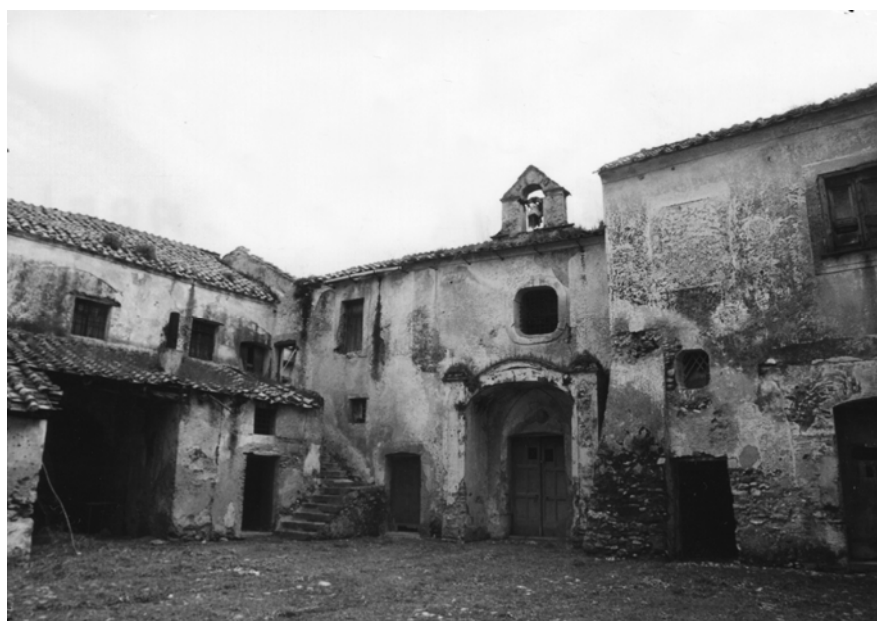
Figura 104. Complesso San Mattia - Particolare.
