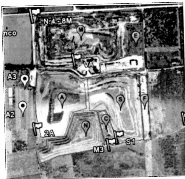
Figura 2. Posizionamento invasi: M: Masseria del Pozzo - E: Area Giuliani - A: Ampliamento Masseria del Pozzo - S: Schiavi — F: Area Fotovoltaico - N: Novambiente - C: confine Novambiente-Schiavi.
