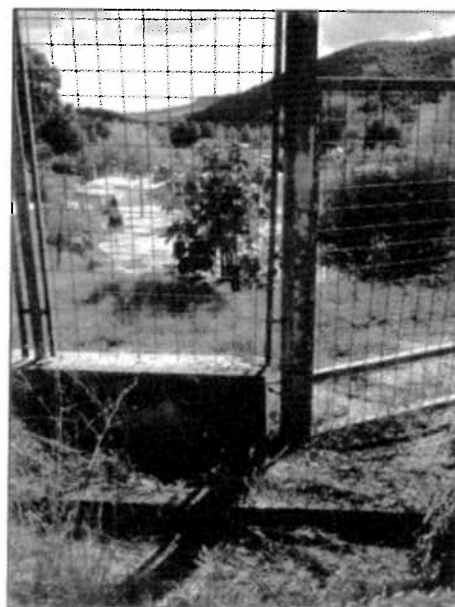
Foto - Vista particolare
