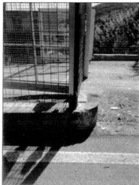
Foto - Vista particolare
