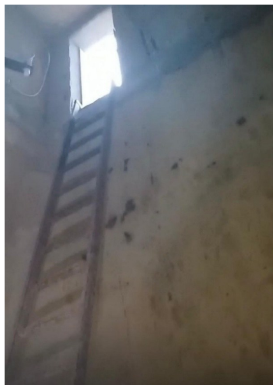
Carpenteria e porta di accesso
